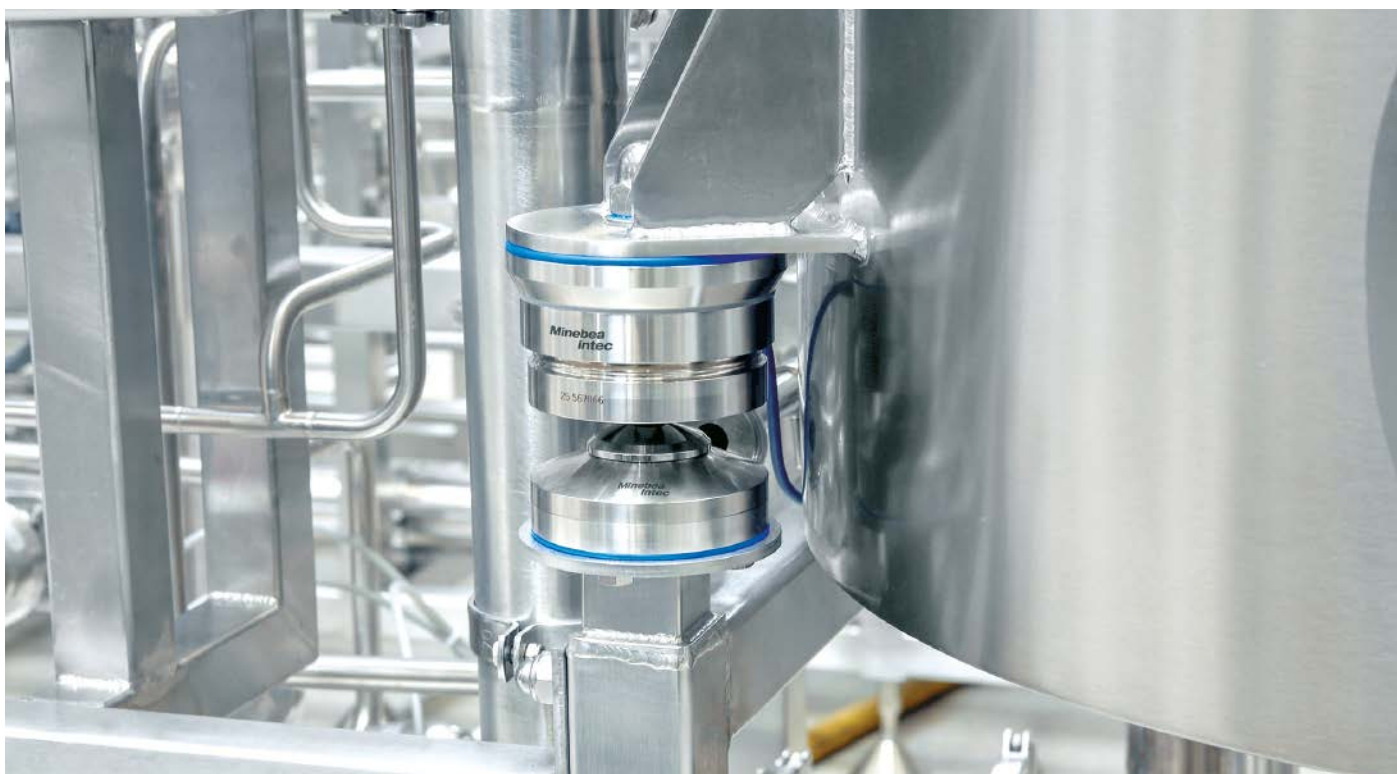
■ Abb. 1: Gelingendes Beispiel einer erfolgreichen Entwicklung. Die Wägemodule der Serie Novego von Minebea Intec bieten einzigartige Vorteile in der Installation und Anwendung.
