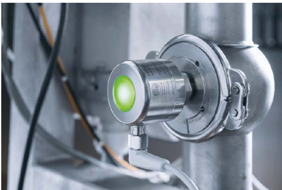
■ Abb. 4: Zukünftig bei Staedler im Einsatz: Der Temperatursensor TCC überwacht sich selbst und erlaubt somit längere Kalibrierungsintervalle. Genauigkeitsabweichungen werden automatisch erkannt und per Schaltsignal und LED signalisiert.
