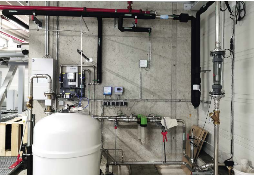
Abb. 1: Bypass Installation am NH 3 Verflüssiger 2,5 MW.
