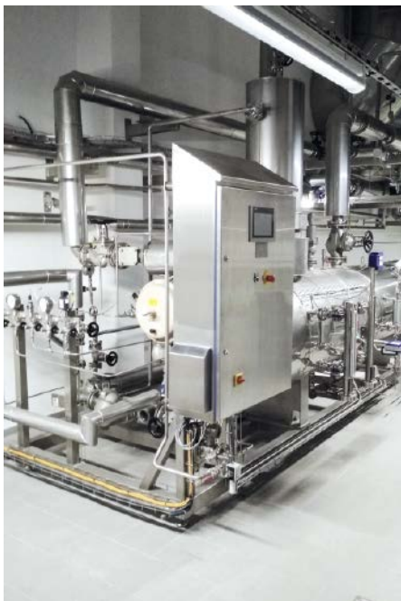
■ Abb. 4: Ein besonderes Puzzlestück im Produktionsprozess: Der Reindampferzeuger von Viessmann ist komplett aus Edelstahl gefertigt und sorgt für höchste Dampfqualitäten bei der Herstellung von Babymilchpulver.
