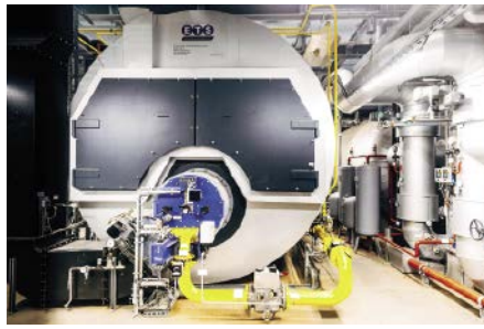
■ Abb. 2: 16 t Dampf pro Stunde liefert dieser sonderangefertigte Kessel von Viessmann für die Produktion von Babymilchpulver bei DMK in Strückhausen.
