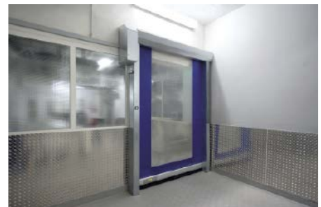
■ Abb. 3: Die Abdeckung der Rolltor Wickelwelle ist schräg ausgeführt, damit Flüssigkeiten ablaufen können und nichts auf den Fahrweg oder Lebensmittel tropft.
