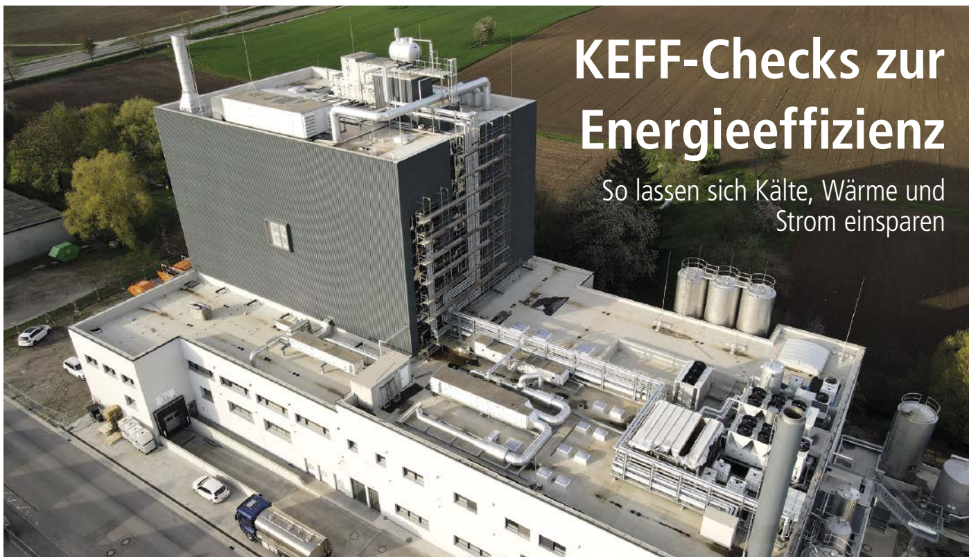
■ Abb. 1: Nach der Inbetriebnahme des neu gebauten Biopolymer-Werks ergaben sich verhältnismäßig hohe Energieverbräuche. Der KEFF-Check machte Einsparungen und Optimierungen möglich.
