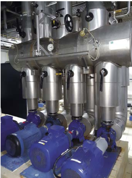
■ Abb. 2: Umbau im laufenden Betrieb: Erst wenn die neue Pumpe störungsfrei im System lief, wurde die nächste Pumpe ersetzt. Die neuen Pumpen und die Frequenzumrichter haben fünf Jahre Gewährleistung.
