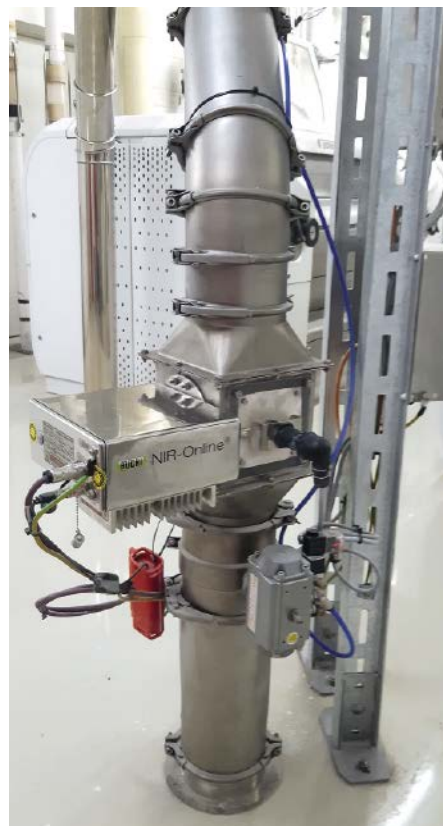
■ Abb. 3: In der Mühle erfolgen die NIR-Online-Messungen direkt in den Reinigungs- und Mahlprozessen für die verschiedenen Mehle.
