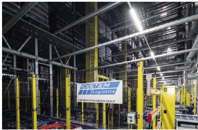
■ Abb. 2: Das neue Hochregallager von System Logistics bietet Platz für rund 23.700 Paletten
