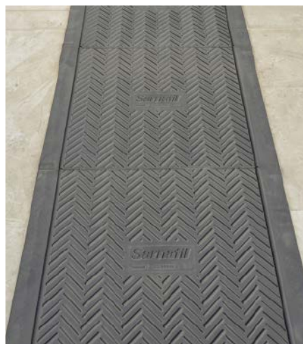
■ Abb. 3: Zur sicheren Wartung der technischen Anlagen auf dem Flachdach wurden 1.500 m Sarnafil Gehwegplatten mit Rutschhemmung der Bewertungsklasse R10 verlegt.
