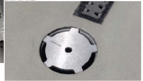
Abb. 3: Das Wasser inkl. Schmutzresten wird in den angeschlossenen Bodenablauf geleitet und kontrolliert in einem Schmutzfangkorb gesammelt.
