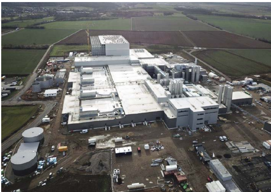
Abb. 1: Der Neubau der Hochwald-Molkerei am Standort Mechernich. Das Flachdach zählt mit 40.000 m 2 zu einem der größten, die mit der FPO-Bahn Sarnafil TG 76-18 FSA abgedichtet sind.
