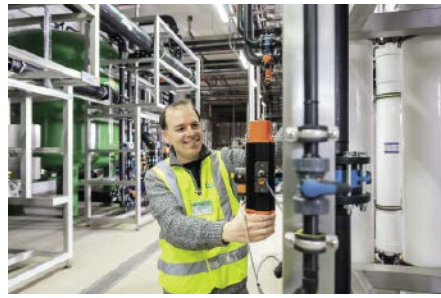
■ Abb. 2: Durch die Aufbereitung von Brüdenkondensat wird der Wasserfußabdruck der Produktion deutlich gesenkt.
