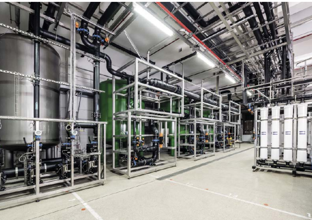
■ Abb. 1: Mit einer Anlage zum Recycling von Brüdenkondensat kann wertvolles Frischwasser gespart werden.
