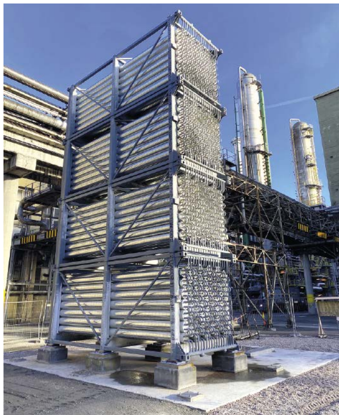
■ Abb. 1: Installation der Wärmespeichermodule beim Düngemittelproduzenten Yara in Porsgrunn, Norwegen.
