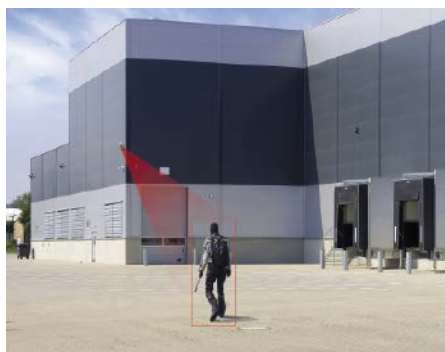
■ Abb. 3: Moderne Videotechnik sorgt mittels intelligenter Bildanalyse dafür, dass ein Schaden gar nicht erst entsteht, da rechtzeitig interveniert werden kann.
