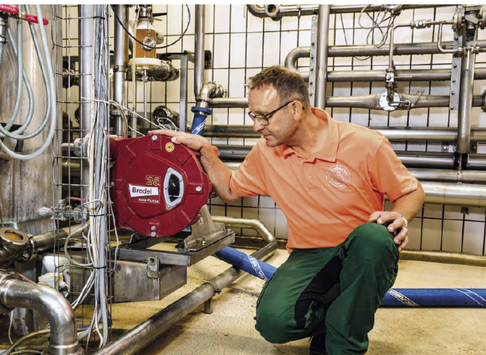
Abb. 1: Nach ca. 1.200 Stunden Betriebszeit, also ungefähr nach sechs Monaten, führen Braumeister Hans-Martin Walz und sein Team in der Regel einen präventiven Schlauchwechsel durch.
