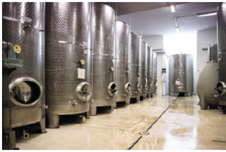
■ Abb. 2: Im Tanklager des Weinguts Fuhrgassl-Huber führen elegante Entwässerungslinien, bestehend aus den Bodenabläufen Eurosink Junior sowie Schlitzrinnen von Aschl, Wasser und Kellerfeuchtigkeit optisch dezent ab.
