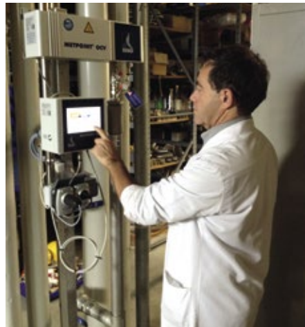
Abb. 2: Das Messtechniksystem überwacht die Druckluftqualität permanent und in Echtzeit.
