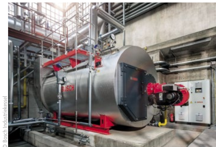
■ Abb. 2: Die neue Dampfkesselanlage fand innerhalb der historischen Brauereigemäuer ihren Platz.
