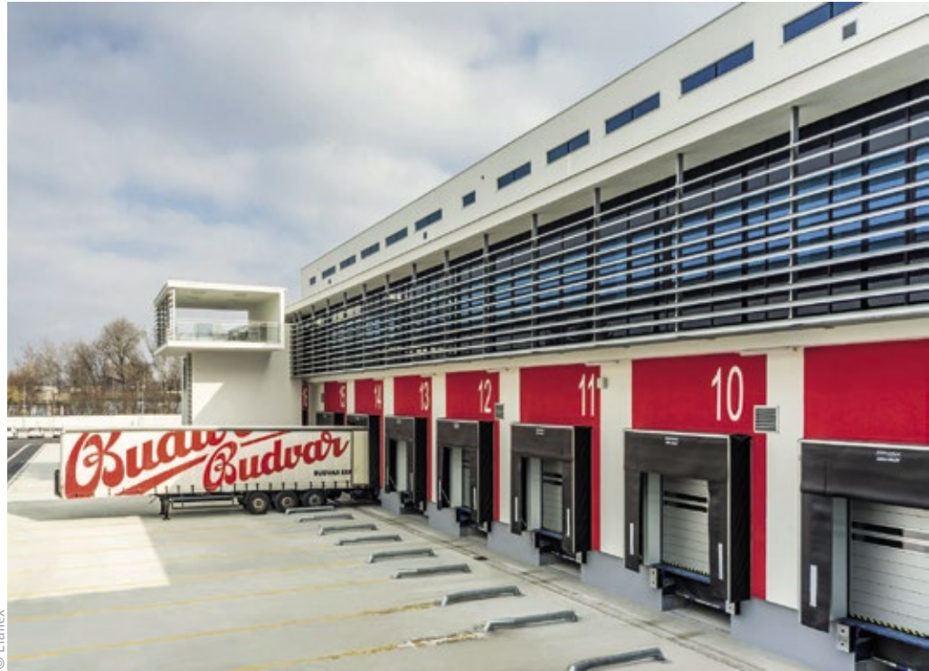
■ Abb. 1: Schnelllauf Tore in der Außenansicht bei Budweiser: Seit April 2018 betreibt die Brauerei ihr automatisiertes Logistikzentrum.
