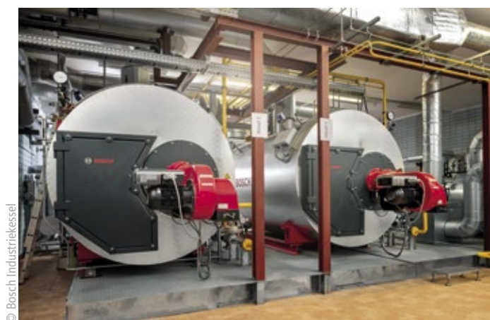
■ Abb. 4: Die Bosch-Kessel in Bellheim versorgen u. a. das Sudhaus für Prozesse wie Maischen und Kochen. Eine Kaskadenregelung sorgt für eine besonders wirtschaftliche Betriebsweise der Mehrkesselanlage.
