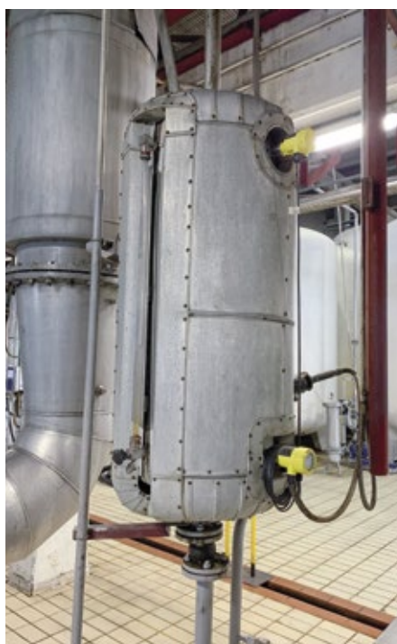
■ Abb. 3: Sensoren des Typs Vegabar 82 überwachen die Aufkonzentration von Weinsäure, ein wichtiger Bestandteil des Grappas.
