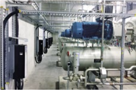
■ Abb. 2: Für höchste Energieeffizienz im Kältemittelkreislauf der Coop-Großbäckerei in der Schweiz sorgen 18 Motoren und 18 Frequenzumrichter von ABB. Die Motoren erreichen bei Volllast einen Wirkungsgrad von bis zu 97 %.
