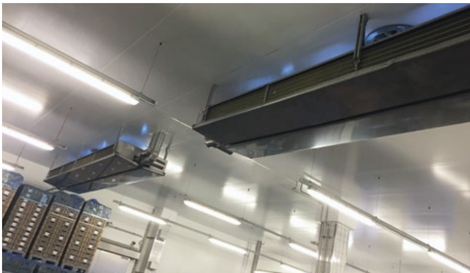
■ Abb. 2: Zum Einsatz kommen UVC-Entkeimungsgeräte aus der E-Serie von Sterilair. Das Schweizer Unternehmen arbeitet bereits seit mehr als zehn Jahren erfolgreich mit Micarna zusammen.
