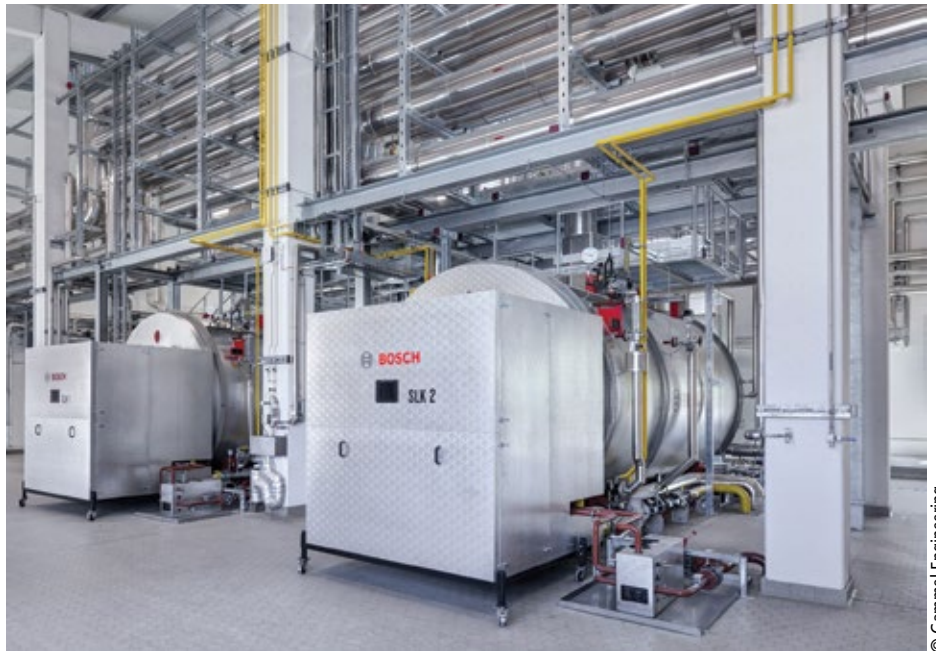
■ Abb. 2: Für die erste Ausbaustufe wurden zwei Spitzenlastdampfkessel mit je 10 t/h Dampf und 10 bar installiert, sodass eine abgesicherte Leistung von 15 t/h garantiert werden kann. In der zweiten Ausbaustufe soll ein dritter Spitzenlastdampfkessel für bis zu 25 t/h Dampf sorgen.
