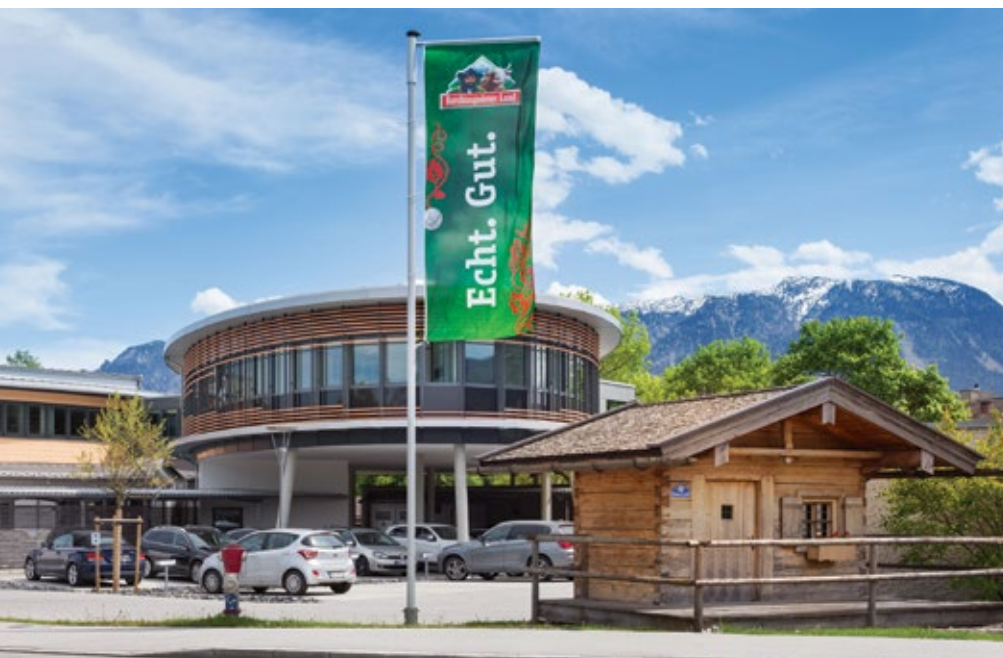
■ Abb. 1: Bei den Milchwerken Berchtesgadener Land in Piding wurde eine neue Energiezentrale mit Erweiterungsmöglichkeiten installiert. Federführend bei der Planung und Ausführung war die Gammel Engineering GmbH.
