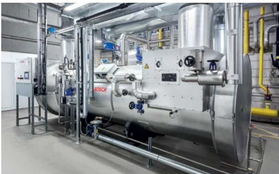
■ Abb. 1: Ressourcenschonend: Der Abhitzedampfkessel HRSB verwertet bis zu 8 t Abgas.
