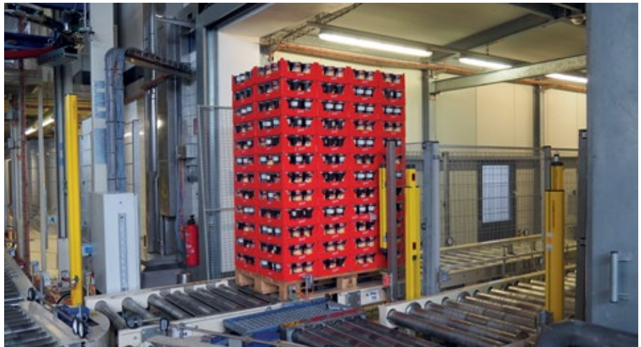
■ Abb. 2: Absicherung der Drehbewegung des Förderbandes mittels Baureihe 46B.
