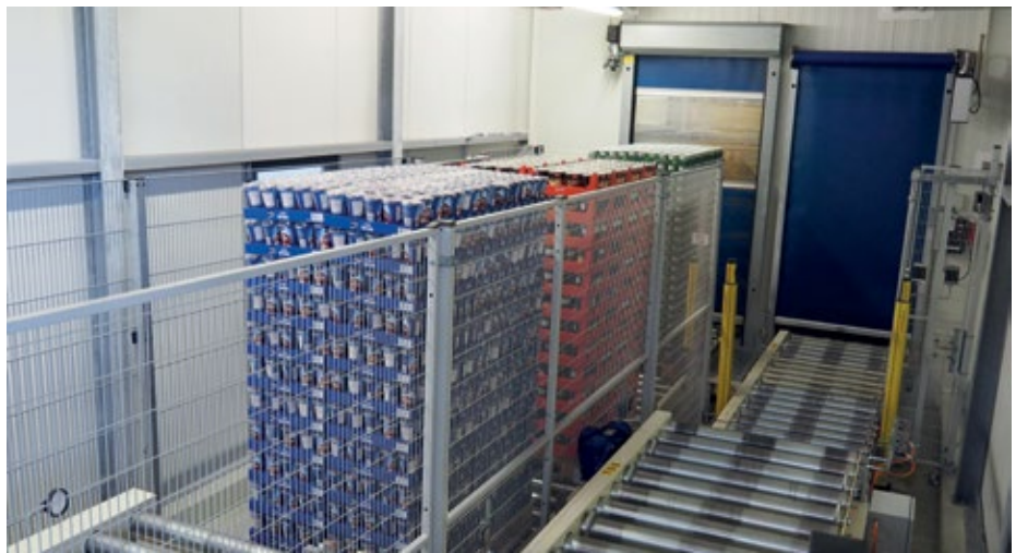
■ Abb. 3: Höhenausgleich vor Einfahrt ins Kühlager.
