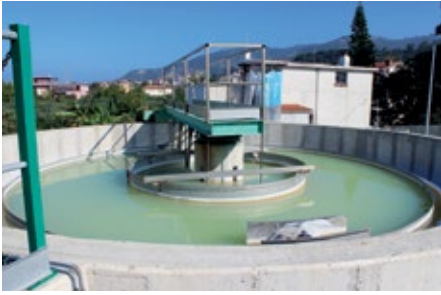
■ Abb. 2: Anstelle eines einzigen, großen Beckens wurden zum Einsparen von Kosten und Energie zwei Becken mit einer Kapazität von jeweils 2.500 m 3 gebaut.
