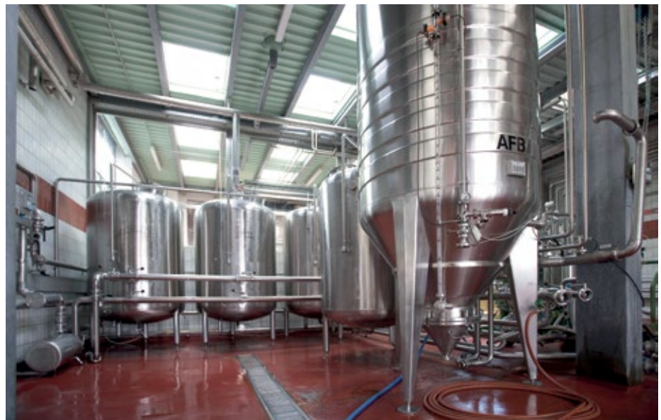
■ Abb. 2: Brauereianlagen nach der Reinigungsphase.
