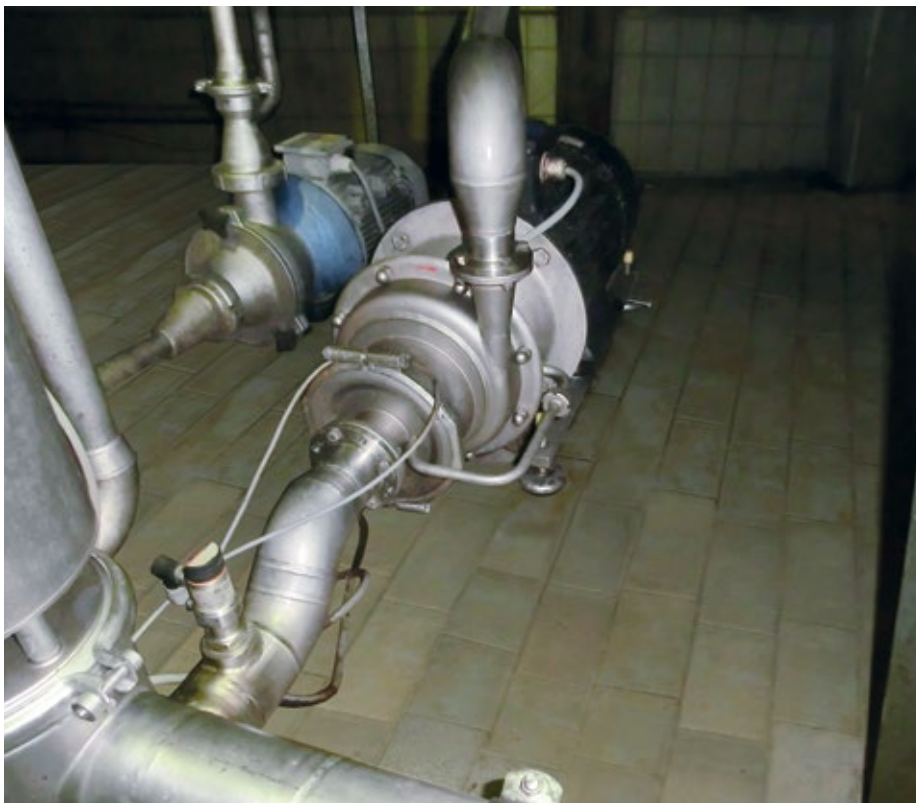
■ Abb. 2: Arbeitet auch bei Schaumbildung ungehindert weiter: die selbstansaugende Pumpe der Serie GEA Tuchenhagen TPS
