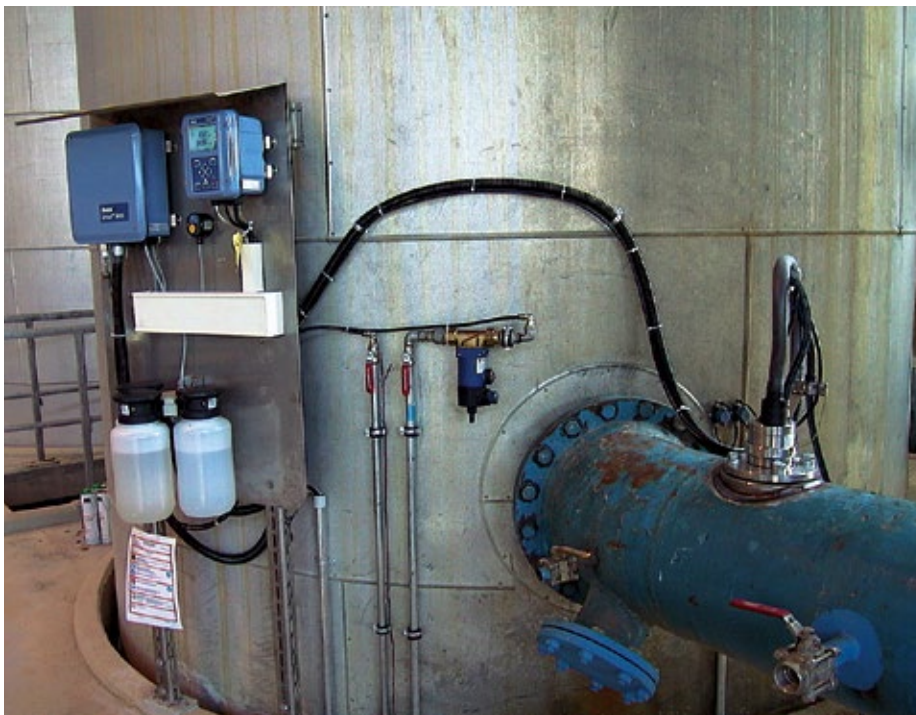
■ Abb. 2: Vollautomatische pH-Messstelle bestehend aus Ceramat WA 150, Unical 9000 C und Portos 3400 C.
