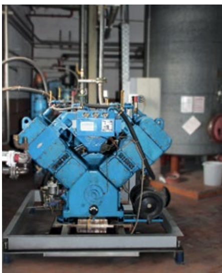
■ Abb. 1: Hat in 31 Jahren rund 240.000 Betriebsstunden gesammelt: Der Champion-Kolbenkompressor bei der Privatbrauerei Egerer.
