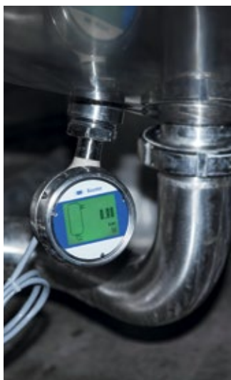
■ Abb. 3: Die Visualisierung eines Tanks statt der Zahlenwerte des gemessenen hydrostatischen Drucks im Display des CombiPress vereinfacht das Ablesen vor Ort.
