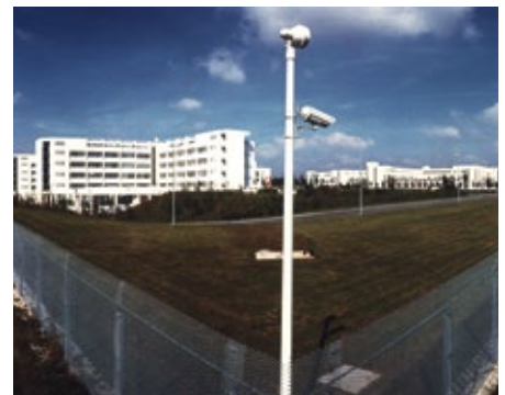
■ Abb. 2: Objektschutz im Freigelände.
