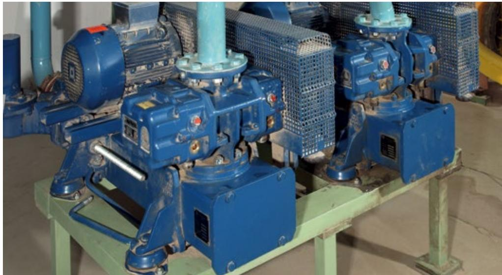
■ Abb. 2: Aerzener Drehkolbengebläse in der zentralen Station.
