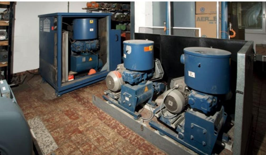
■ Abb. 3: Drei Aerzener Drehkolbengebläse mit teildemontierter Schalldämmhaube in einem Nachbarraum.
