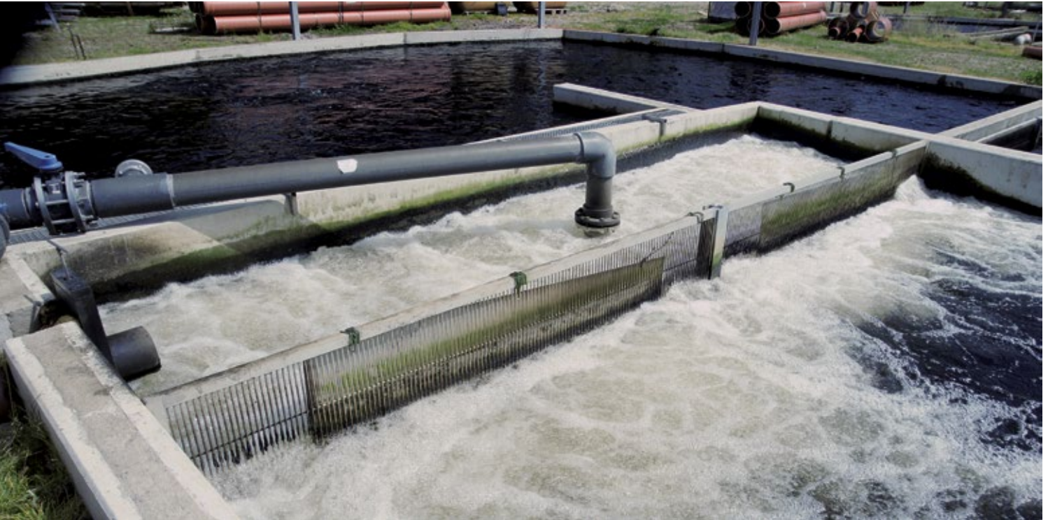
■ Abb. 1: Auch Lachsforellen leben nur mit Sauerstoff. Das Bild zeigt den Eintrag von Sauerstoff in ein Kreislaufbecken.
