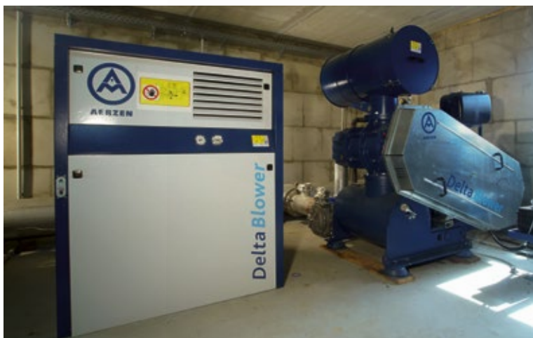
■ Abb. 2: Detailbild aus der zentralen Sauerstoff-Station: Ein elektrisch angetriebenes Drehkolbengebläse (links) und ein über einen Dieselmotor angetriebenes Drehkolbengebläse der neuen Baureihe Delta Blower „Generation 5“ (rechts).
