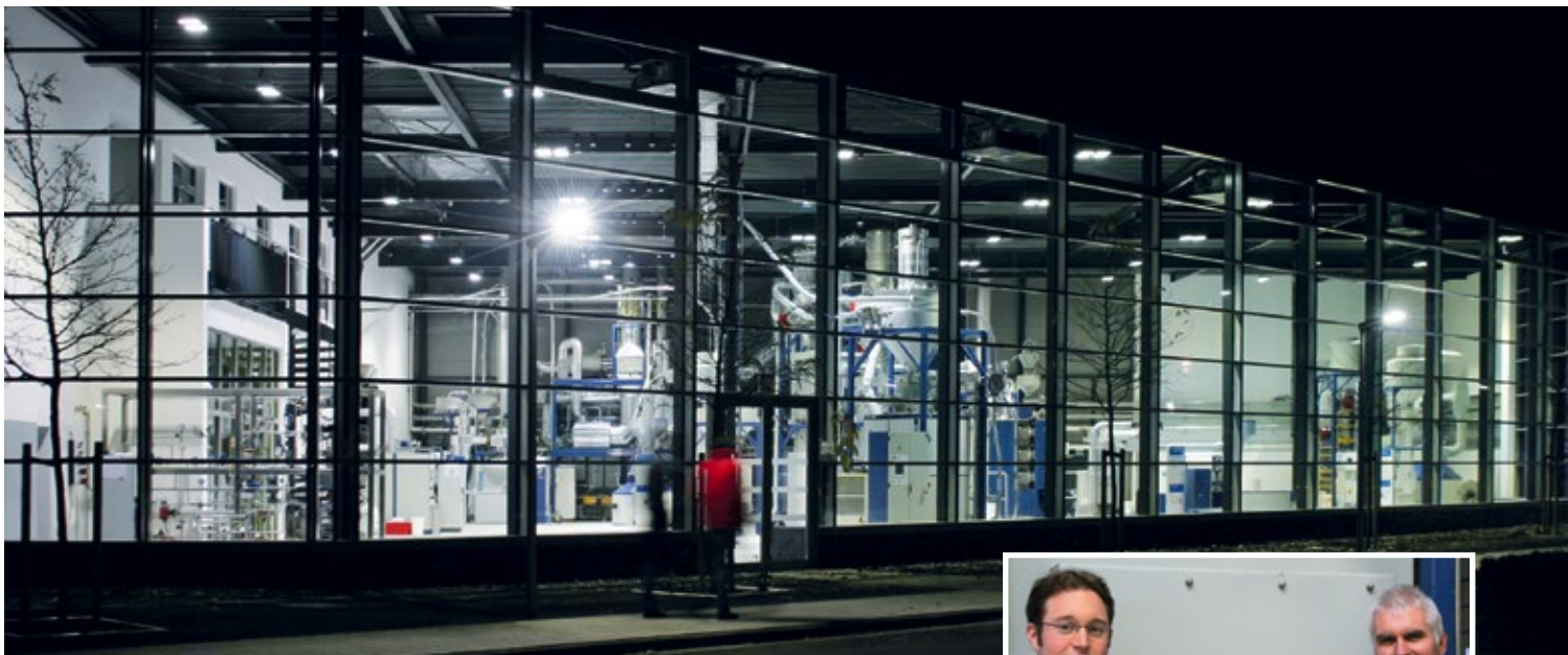
■ Abb. 3: Das neue Technikum der Probat-Werke.
