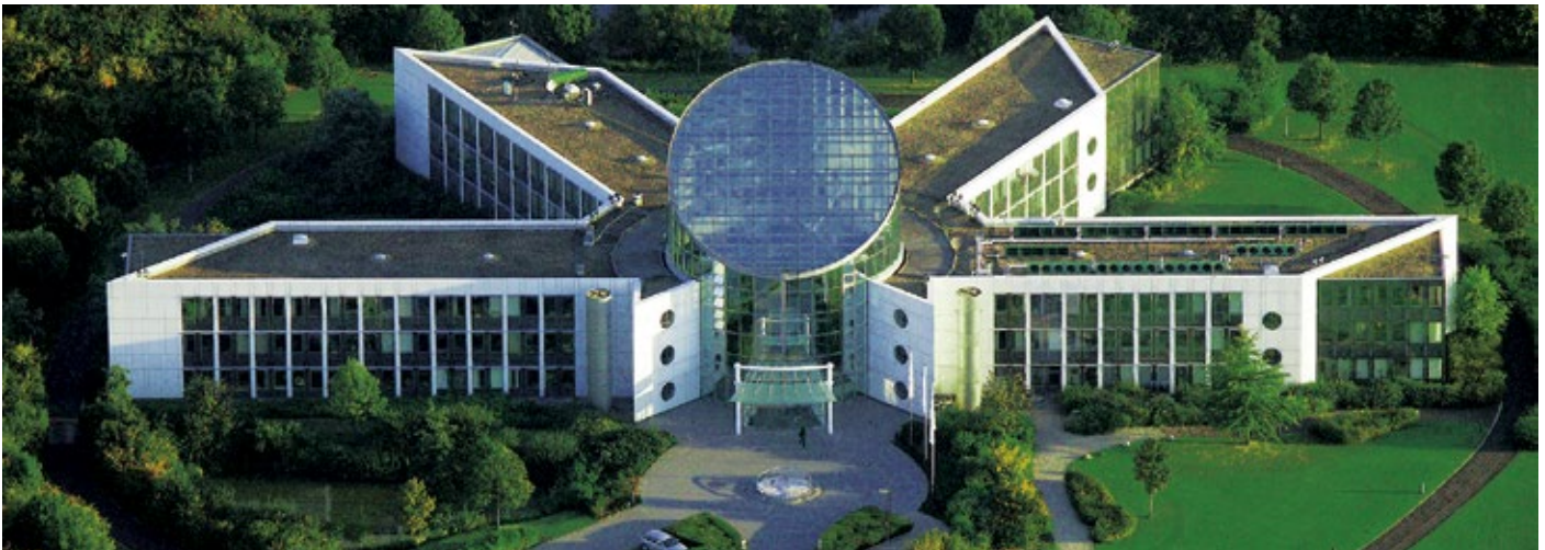
■ Abb. 3: Die ehemalige GEA-Firmenzentrale in Bochum ist heute Hauptstandort der Segmente GEA Heat Exchangers und GEA Refrigeration Technologies.
