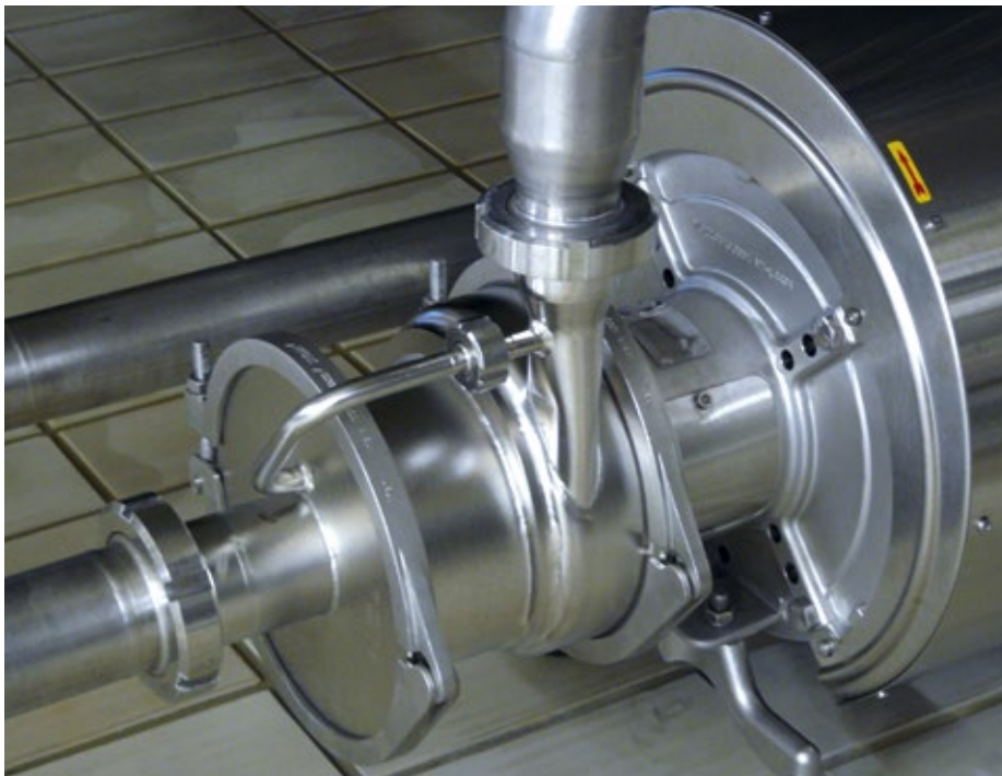
■ Abb. 3: Die GHP sammelt aufgrund ihres höheren Wirkungsgrades gegenüber einer Seitenkanalpumpe weitere Pluspunkte, da Erdinger Weißbräu ein zertifiziertes Energiemanagementsystem betreibt.
