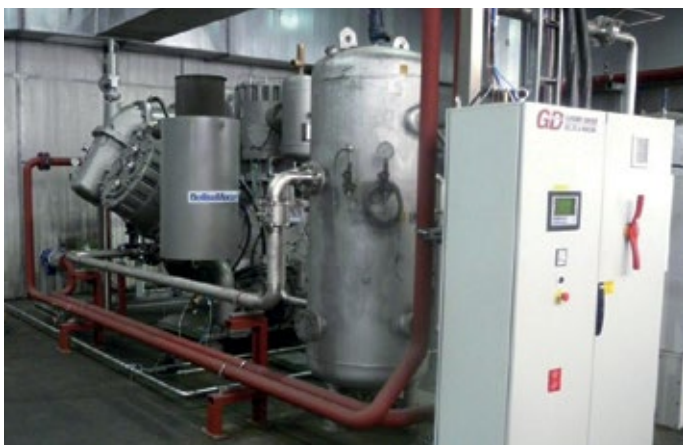
■ Abb. 3: Der neue dreistufige 40 bar-Kolbenkompressor liefert bis zu 1.950 m 3 /h ölfreie Druckluft für die Produktion von PET-Flaschen. © Compair
