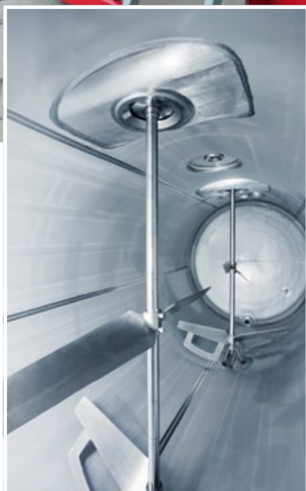
■ Abb. 2: Die Rührwerke gewährleisten durch die Bewegung des beheizten Produktes die gleichbleibende Temperatur. Eine übermäßige Sedimentation anderer Güter wird verhindert.
