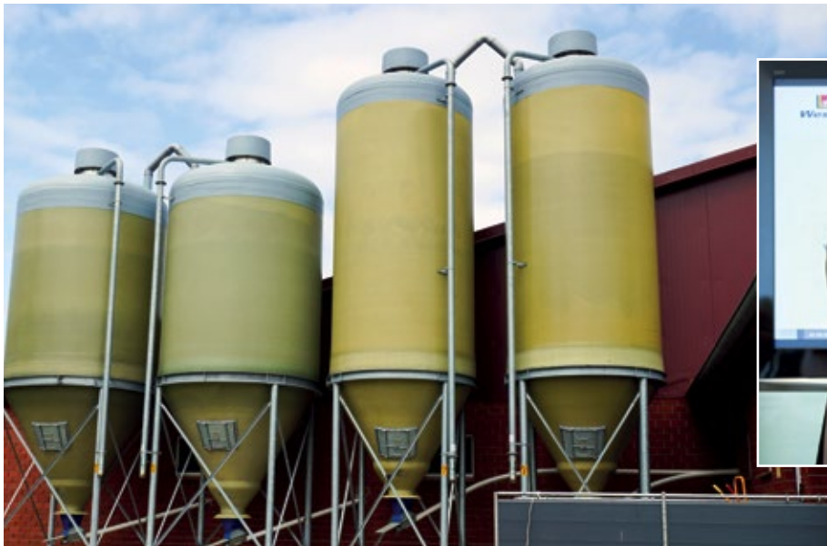
■ Abb. 1: Das Risiko der Selbstentzündung, z. B. bei Schüttgütern in Futtersilos, stellt eigene Anforderungen an Präventiv- und Brandschutzmaßnahmen.
