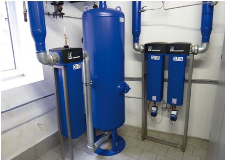
■ Abb. 2: Die neue Aufbereitungslösung im Brandt-Schokoladenwerk Landshut mit Clearpoint Fein- und Clearpoint Feinstfilter sowie dem Clearpoint V Aktivkohleadsorber mit integriertem ölfreien Staubfilter für öl- und partikelfreie Druckluft.
