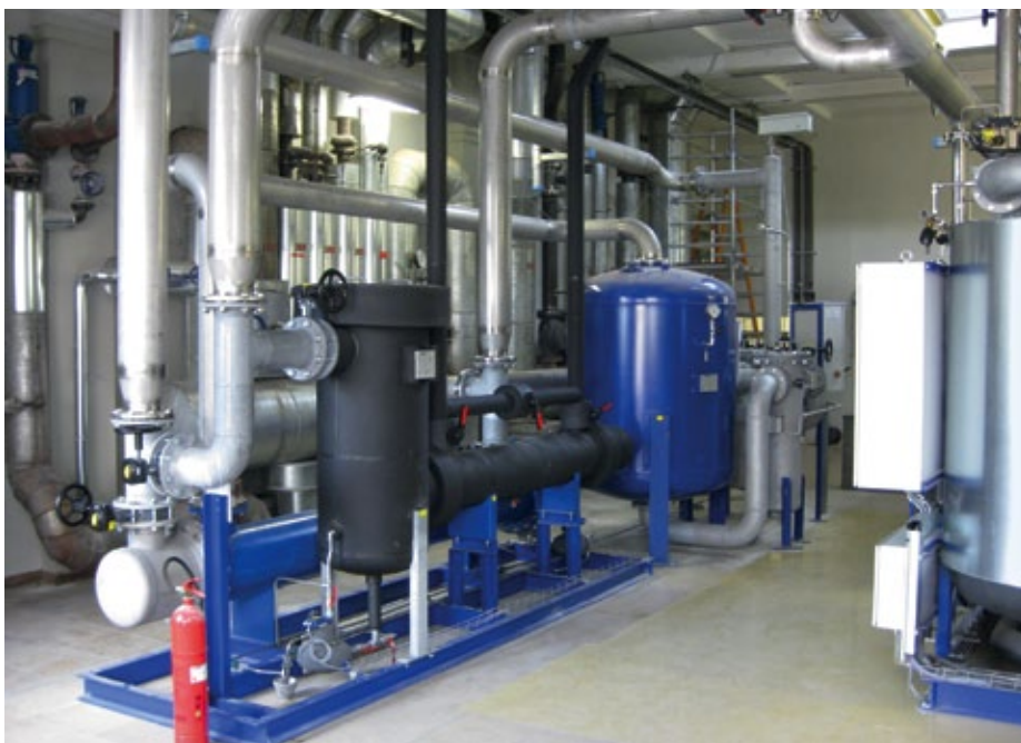
■ Abb. 2: Durch die Vorkühlung der Druckluft kann ein Everdry-Adsorptionstrockner vom Typ 3400 FRA auch eine Überlast von bis zu 5.000 \text{ m}^3/\text{h} sicher bewältigen. © Beko
