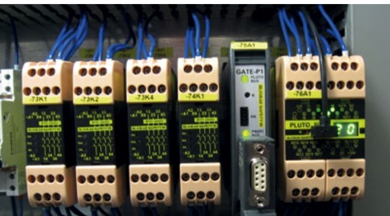
■ Abb. 2: Der Sicherheitscontroller Pluto, rechts, mit Profibus DP Gateway kann mehrere Anlagenteile vernetzen. Links erkennt man die Erweiterungsrelais BT50 und BT51. © ABB Jokab Safety
