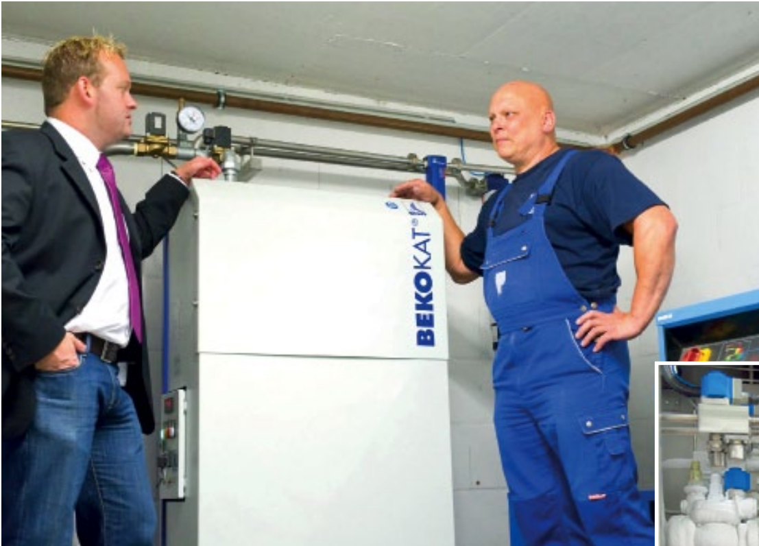
■ Abb. 1: Ein Bekokat-Gerät sichert die Qualität der gesamten Druckluftversorgung im Heinsberger Werk von Rosen Eiskrem. Frank Rütten, Verantwortlicher für alle Energien bei Rosen Eiskrem, im Gespräch mit Beko-Vertriebsmitarbeiter Marcel Schnitzler (links).
