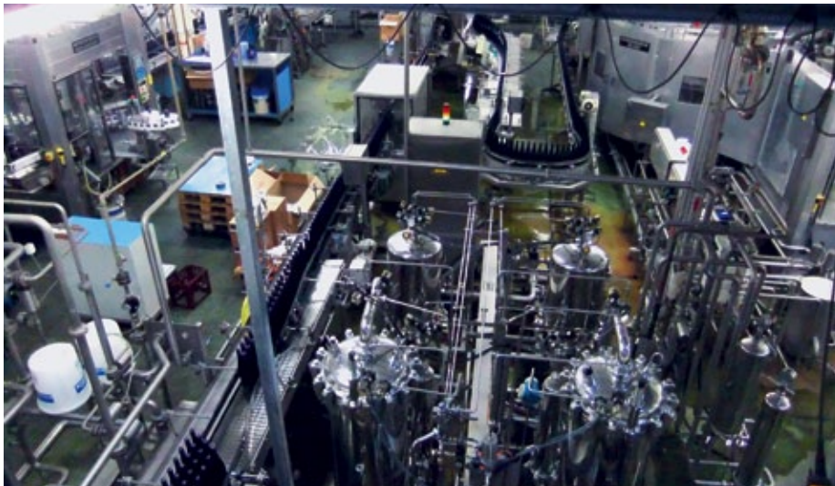
Abb. 2: Bei der Produktion legt das Weingut besonders viel Wert auf Energieeffizienz. © Bilder: Almig Kompressoren
