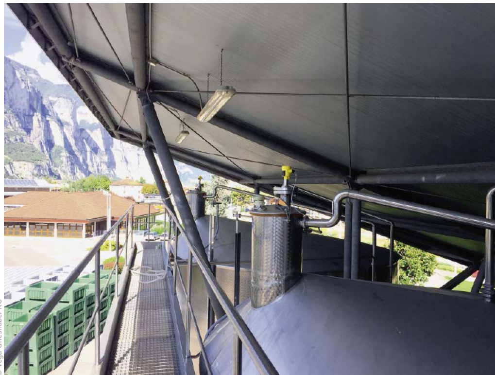
■ Abb. 3: Der Sensor wurde auf einer Art Schornstein mit einer Höhe von 50 cm und einem Durchmesser von 40 cm auf dem Tank installiert.
