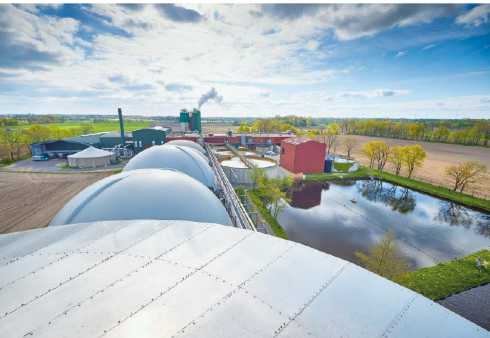
Abb. 1: Das Entsorgungszentrum: Darstellung der Abwasserbehandlungs- und Biogasanlage.
