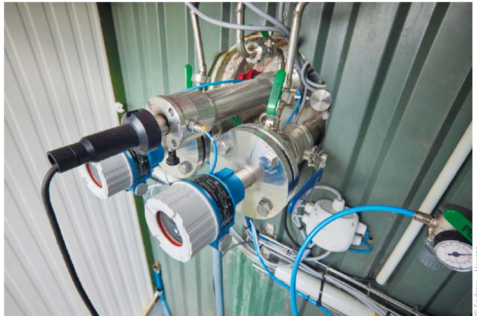
■ Abb. 3: Füllstand- und pH-Messung am Hochfermenter: um den reibungsfreien Betrieb sicherzustellen ist die Messstelle mit einer Wasserspülung ausgestattet.
