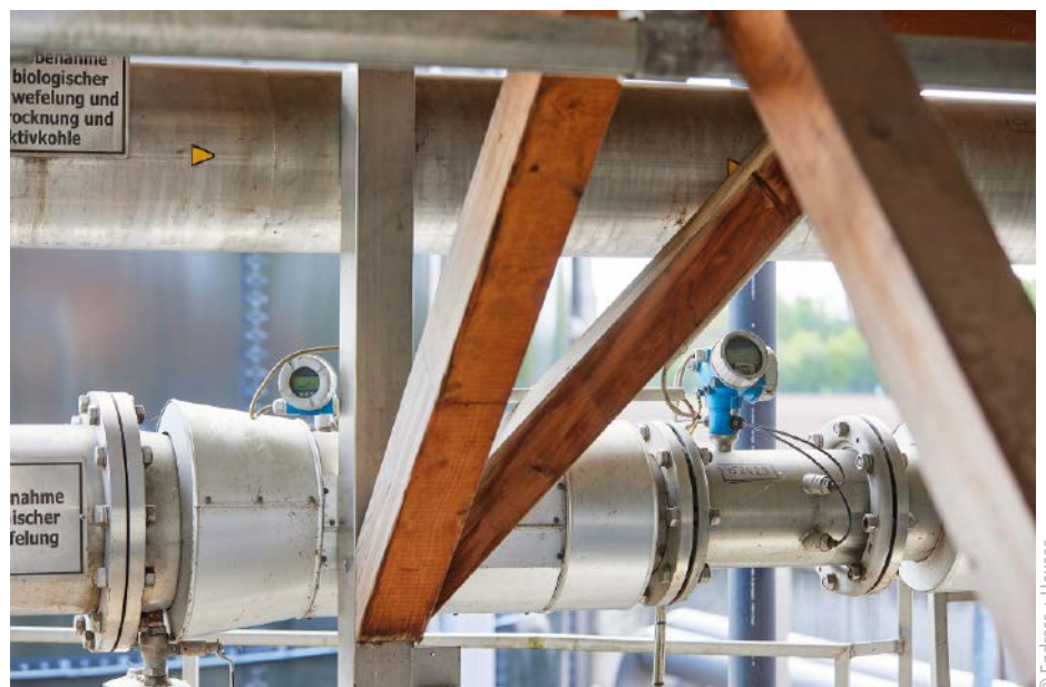
■ Abb. 4: Prosonic Flow B200: das Ultraschall-Durchflussmessgerät erfasst die Biogasmengen inklusive dem Methangehalt.
