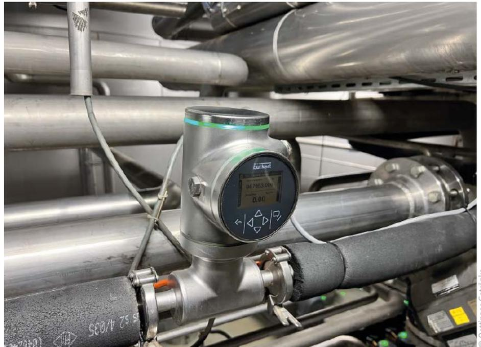
■ Abb. 2: Für die Dosierung und Messung von Hopfenextrakt wurde vor dem Zulauf zur Würzpfanne ein SAW-Durchflussmesser installiert.
