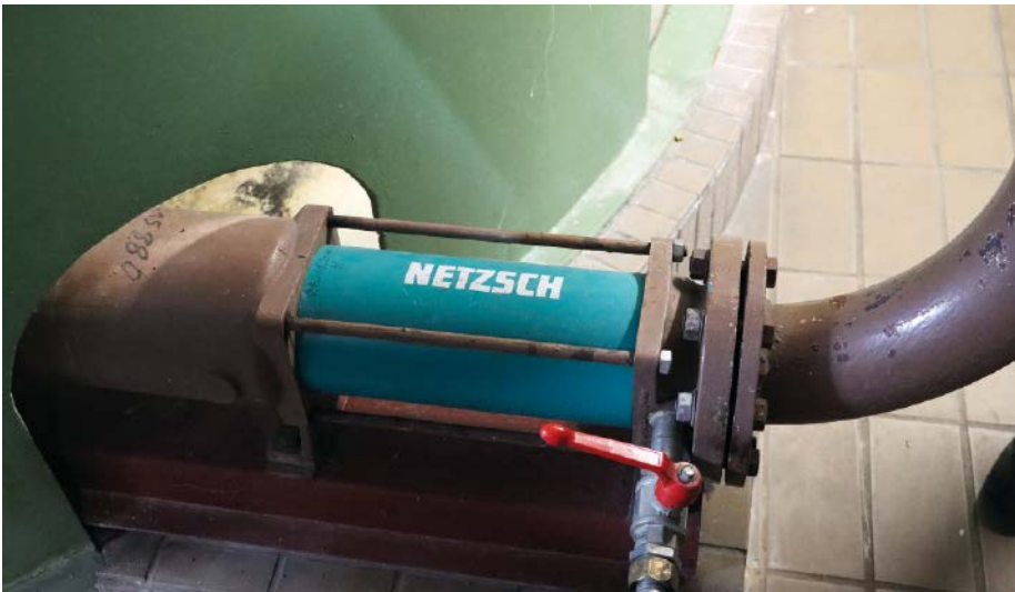
■ Abb. 2: Seit 1982 ist bereits eine Nemo Exzenterschneckenpumpe von Netzsch zur Treberförderung bei Müllerbräu störungsfrei im Einsatz.
