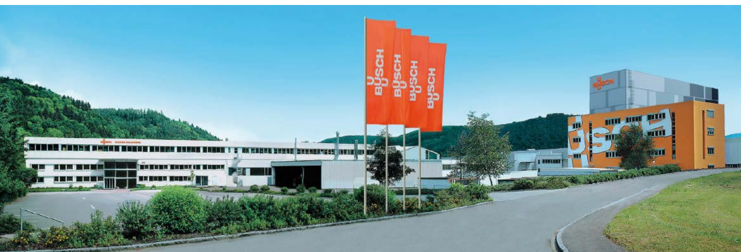
Abb. 1: Die Busch Group (im Bild der Hauptsitz in Maulburg) ist weltweit einer der größten Hersteller von Vakuumpumpen, Vakuumsystemen, Gebläsen, Kompressoren und Abgasreinigungssystemen.
